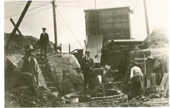
47 Der Sammelbrunnen der Rohwasserleitung zu den Filtern erhielt den letzten Ring aus gemauerten Ziegelsteinen, bevor der Schieberschacht gemauert wurde. Die Abbildungen 44–47 stammen alle aus den Jahren vor dem Ersten Weltkrieg.
