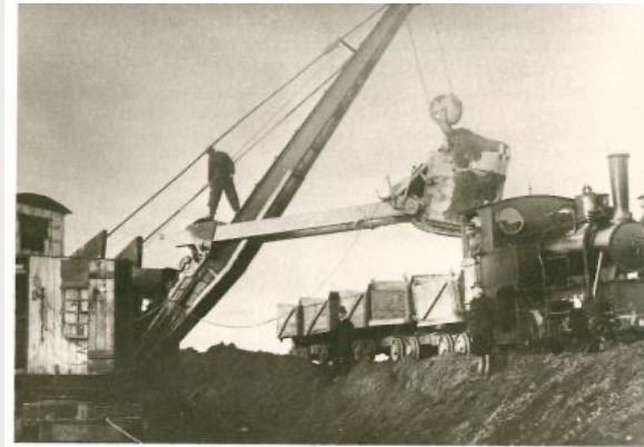
44 Die Ausbaggerung der Baugrube für die Vorkläranlage in der Wassergewinnung geschah mit Dampfkraft.
